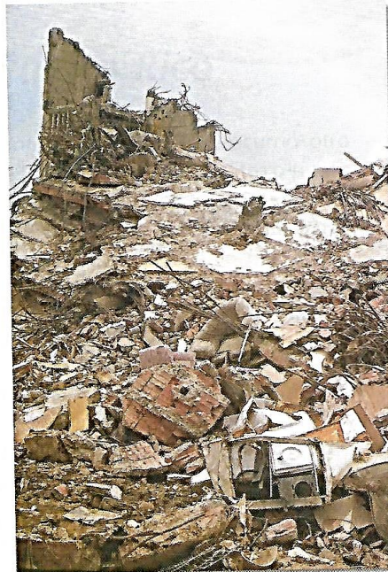
Destrozos ocasionados por un terremoto en Cariaco, Venezuela
